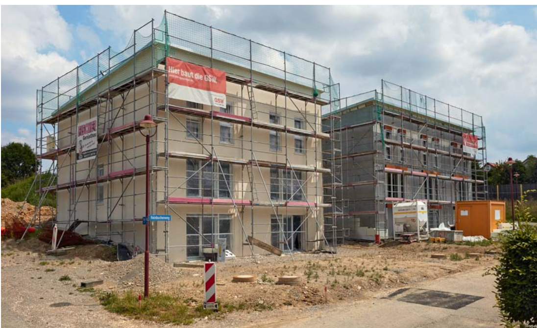
Baustelle „Wohnen am Ziegelesch“ in Sigmaringen
