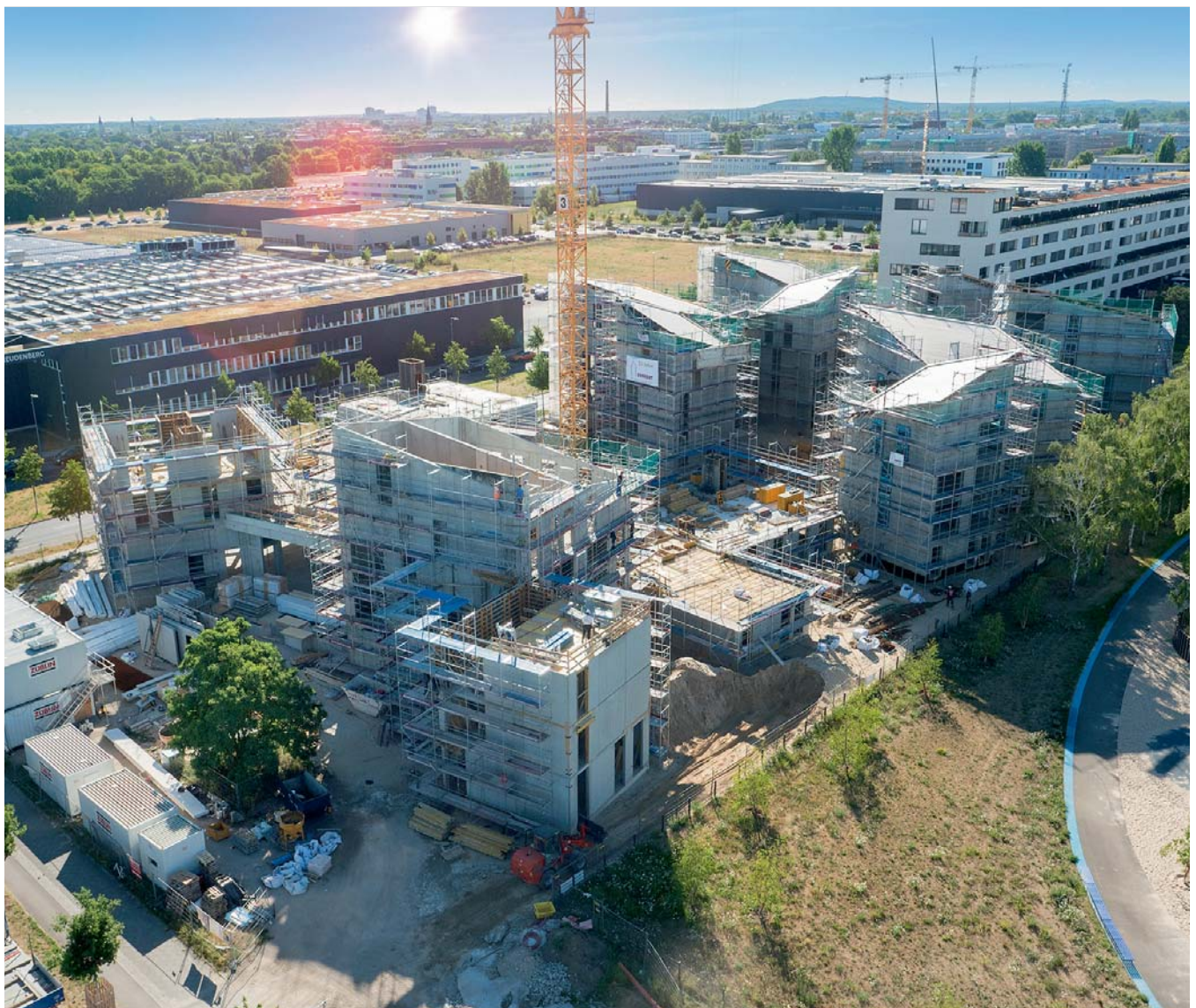
Baustelle des Projektes „Future Living Berlin“ in Berlin-Adlershof
