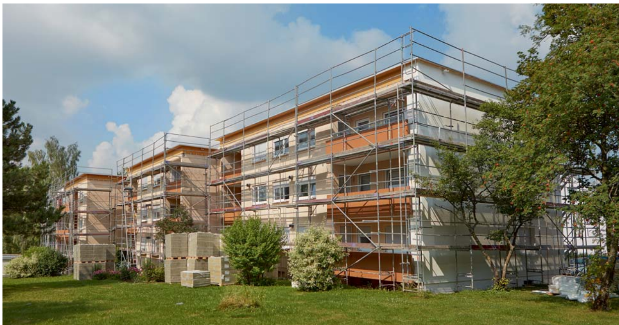
Instandhaltungsmaßnahmen in der Linachstraße in VS-Schwenningen
